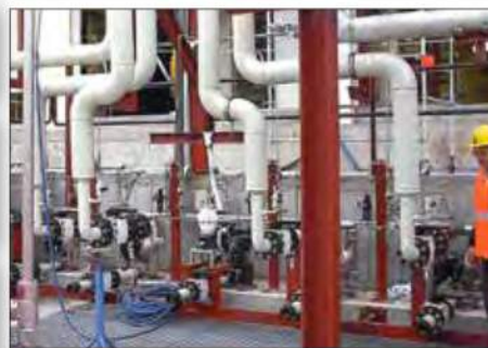
2" (50,8 mm) Doppelmembranpumpen zusammen mit PVDF Pulsationsdämpfern in einer Anlage eingebaut für die Beladung von Fluorwasserstoffsäure.
