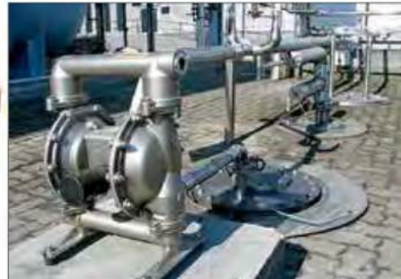
1 1/2" (38,1 mm) Doppelmembranpumpe installiert in einem Betrieb zur Förderung von Chemikalien (Chlorid-Methylen Verbindungen).
